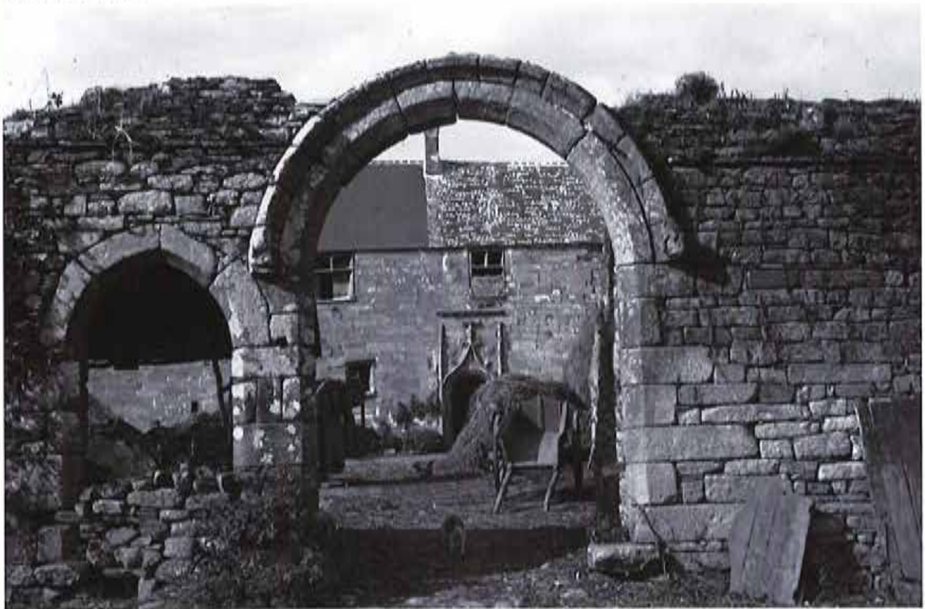
Porche d'entrée du manoir de Lesnarvor vers 1930 (AD29, 14 Fi 608).
