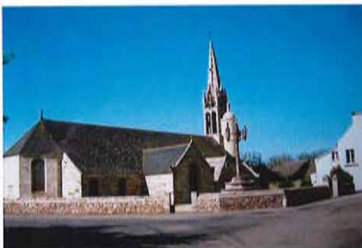
Eglise Saint-Gorgon après les travaux de restauration des extérieurs et la construction du mur d'enclos
