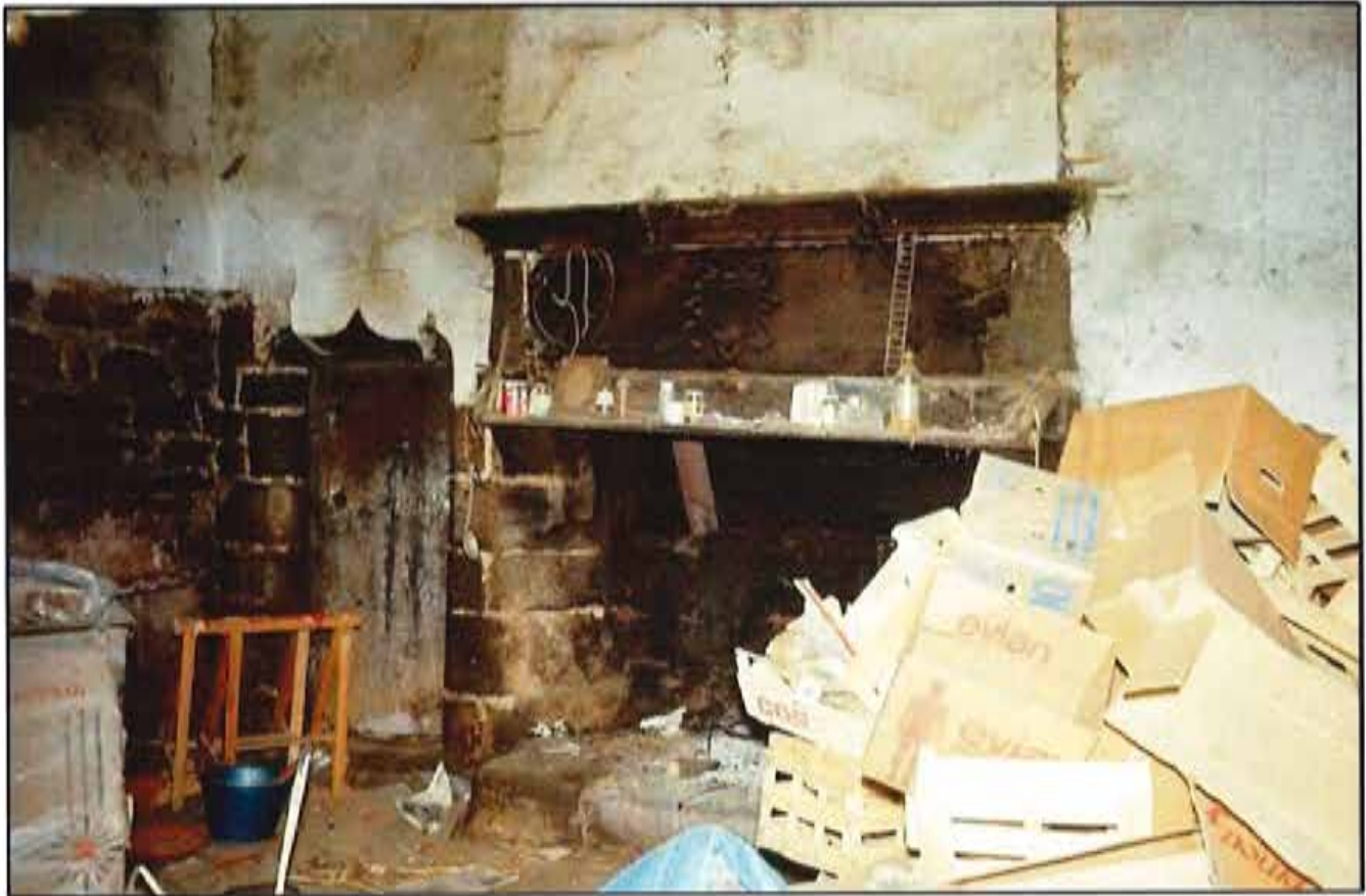
En 1975, le manoir ne servait plus d'habitation mais de bâtiment agricole. Sur le linteau de la cheminée, on distingue un blason. À côté, on voit une porte en accolade (AD35, 40 FI 2820).
